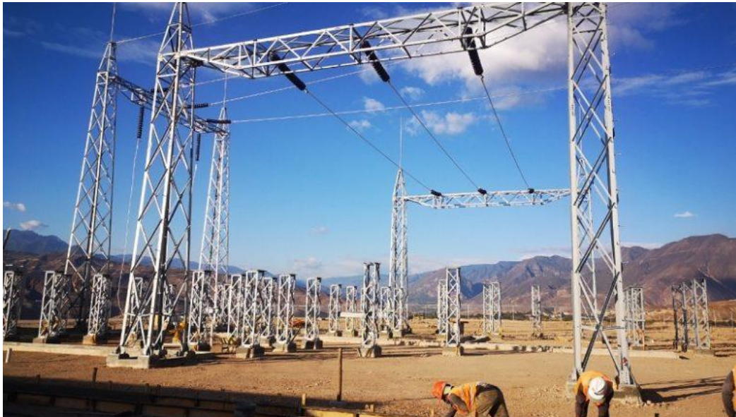
Ilustración 37. Avance constructivo del Proyecto eólico Minas de Huascachaca, septiembre de 2020
