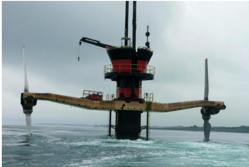
Ilustración 14. Sistema SeaGen desarrollado por Marine Current Turbines Ltd. , Reino Unido, para producción de energía mareomotriz (Quintero y Quintero, 2015)
