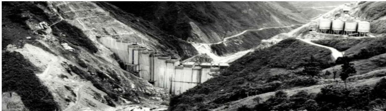
Ilustración 5. Construcción de la represa Daniel Palacios Izquierdo (HIDROPAUTE CELEC_EP)
