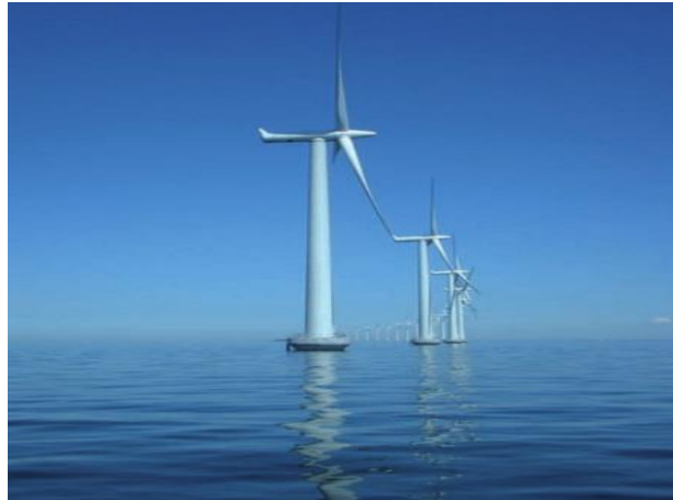
Ilustración 22. Parque eólico offshore
